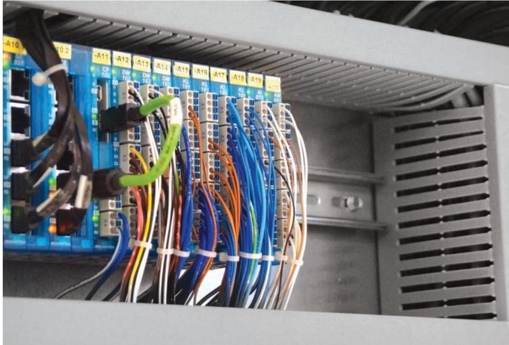
*Das kompakte »S-Dias«-Steuerungssystem von Sigmatek übernimmt die gesamte Regeltechnik des Dosiersystems sowie die Rezeptverwaltung.*
