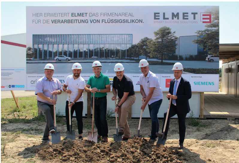
Der Oftringer Bürgermeister Dietmar Lackner mit Eigentümer-Vertreter Daniel Reslhuber, den Gründern und Eigentümern Kurt Manigatter, Paul Fattinger und Karl Adlesgruber von ELMET sowie LAbg. Bgm. Christian Kolarik beim Spatenstich zur neuen Halle.
